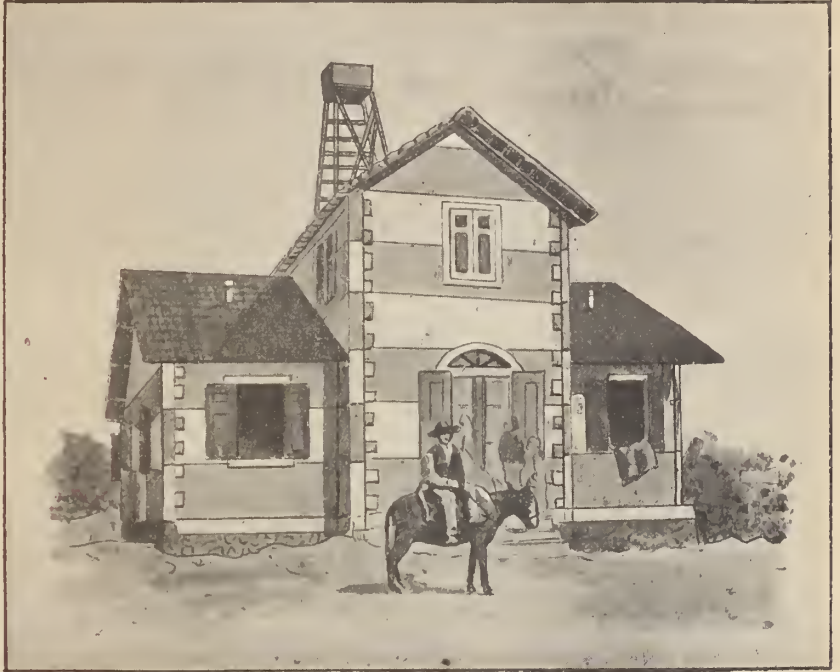
126 — Estabelecimento thermal de Alcanhões
