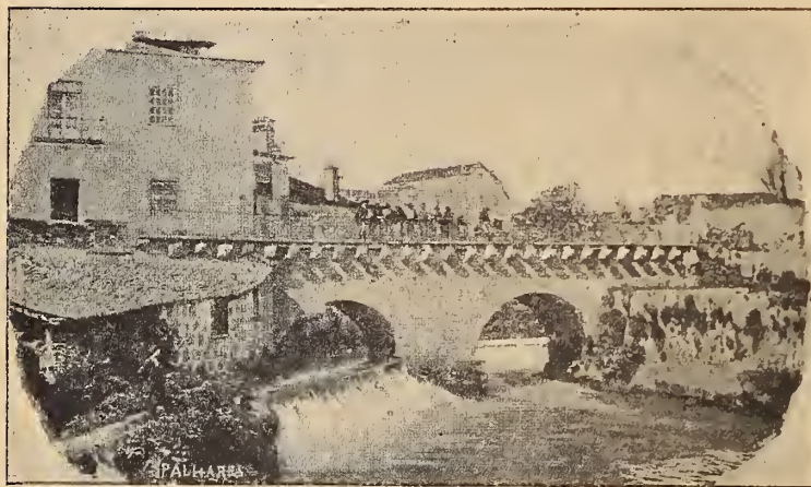
158 - Ponte da Levada
