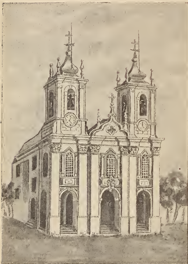
83 - Igreja de Santa Quiteria de Meca
