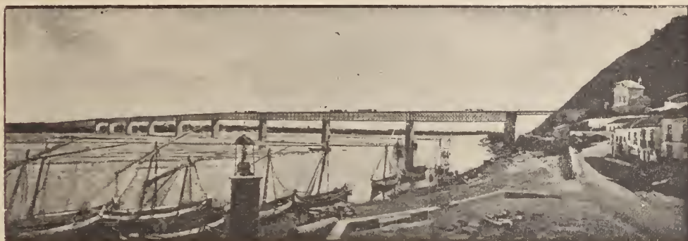
110 — A Ponte de Santarem
