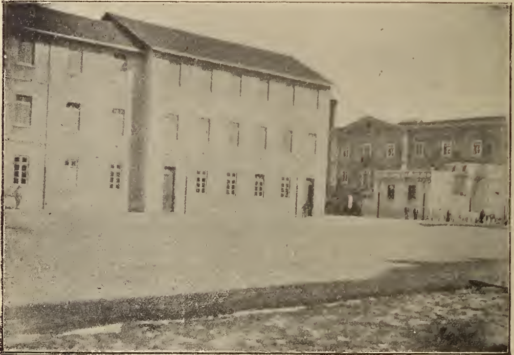
3o — Fachada do quartel das Subsistencias e edificio da Manutenção Militar
