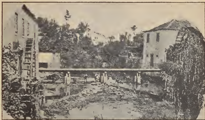
159 - Ponte de Lamego
