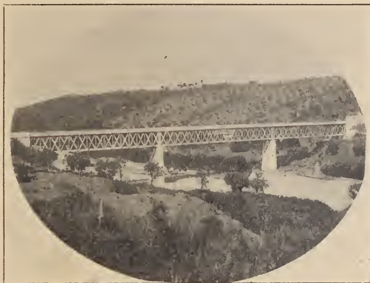
215 — Vista da ponte sobre o Zézere
