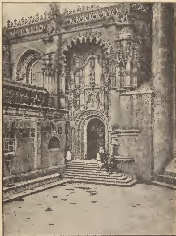
191 — Fachada da igreja de Christo
