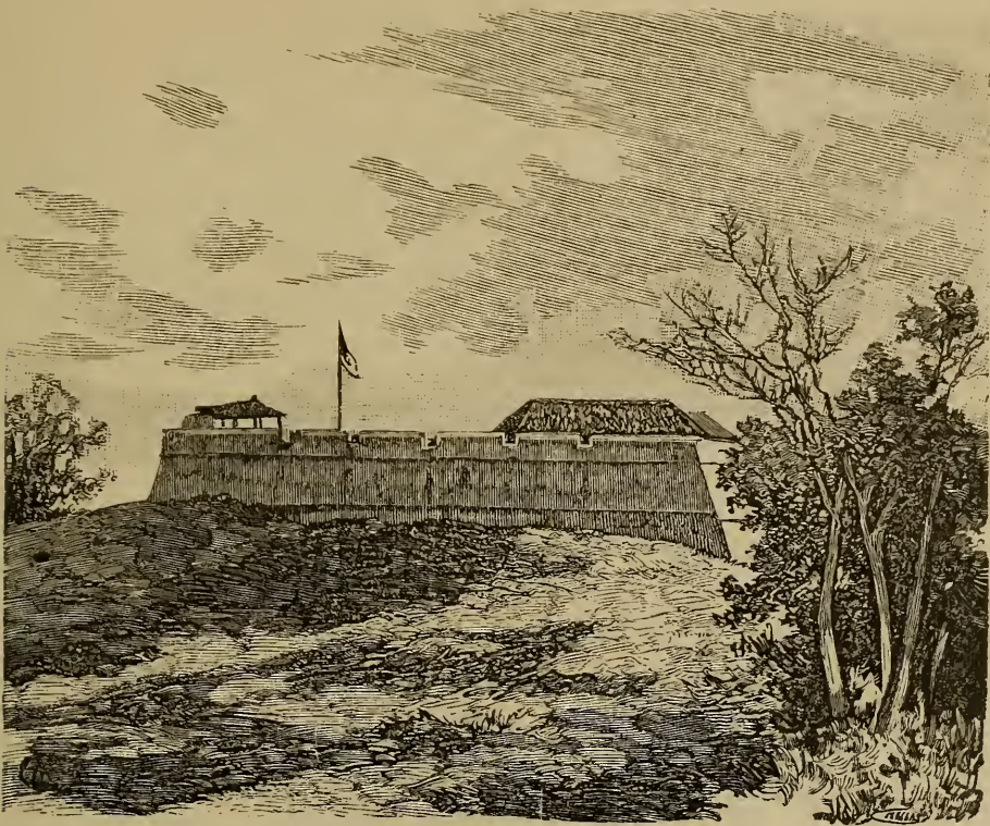
FORTALEZA DE S. SEBASTIÃO (ILHA DE S. THOMÉ)
