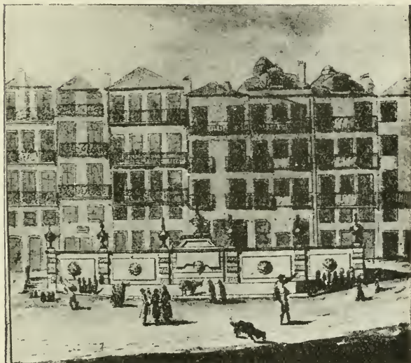
O tanque da Praça Nova
