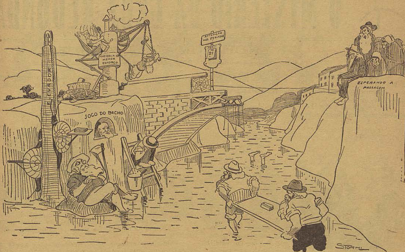
Annuncia-se para breve a inauguração da Ponte do Rio Joanna cujos trabalhos foram iniciados na era da primeira mocidade do rei Henrique (D. João Charuto). Aqui estampamos um aspecto das obras quando iam em meio (1890).
