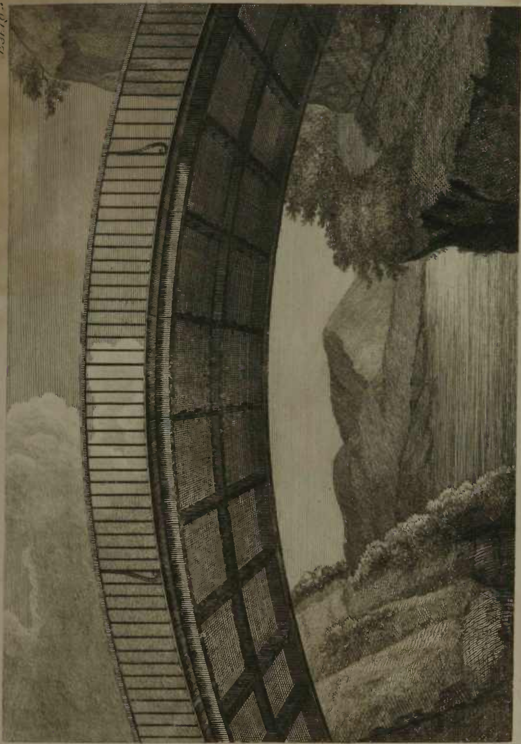
Parte d' una ponte composta de aduelas de ferro.
