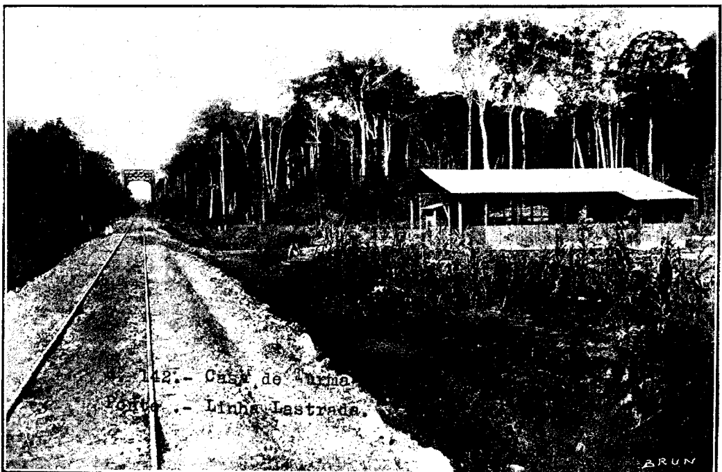
Fig. 15. — Barracão para abrigo de trabalhadores no meio de linha, á prova de mosquito : construções de E. de F. Madeira e Mamorê.
