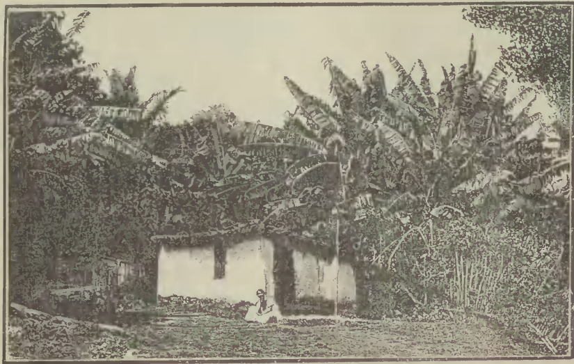
Dawny dom mieszkalny na fazendzie.
