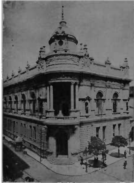
CAIXA DE CONVERSÃO
