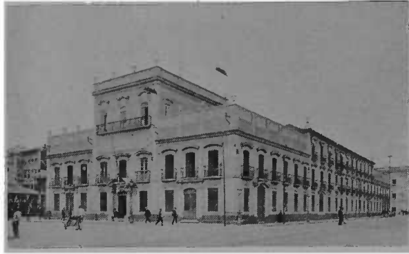
Repartição Geral dos Telegraphos
