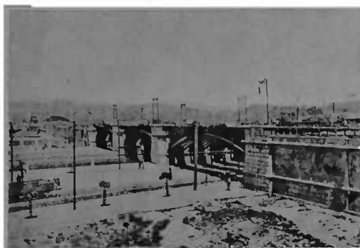
R. F. Central do Brasil, Viaducto entre S. Diogo e S. Christovam
