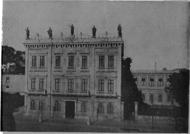
FACHADA DO PALACIO PRESIDENCIAL, NO CATTETE.
