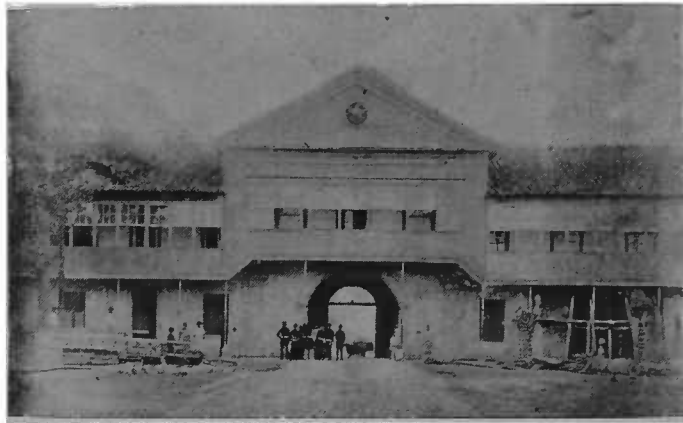
PARTE INTERNA DO ANTIGO EDIFÍCIO DO MINISTERIO DA GUERRA.
