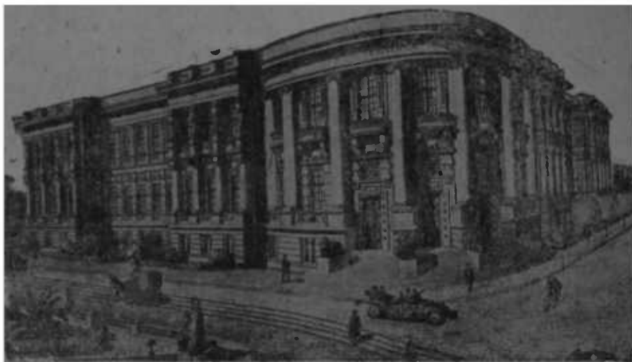
EDIFÍCIO EM CONSTRUÇÃO
