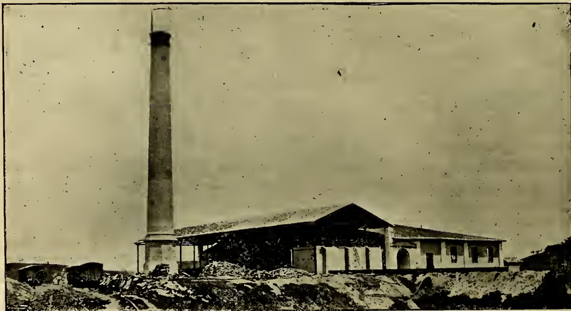
Vista geral da fabrica de assucar «Pitanga», no municipio da Matta de S. João
