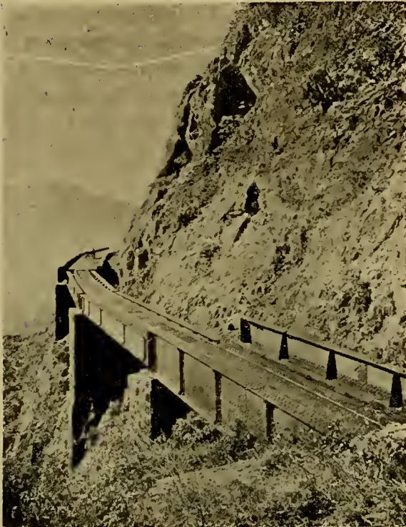
Engenharia brasileira : O celebre viaducto « Carvalho » na ferro-via do Paraná
