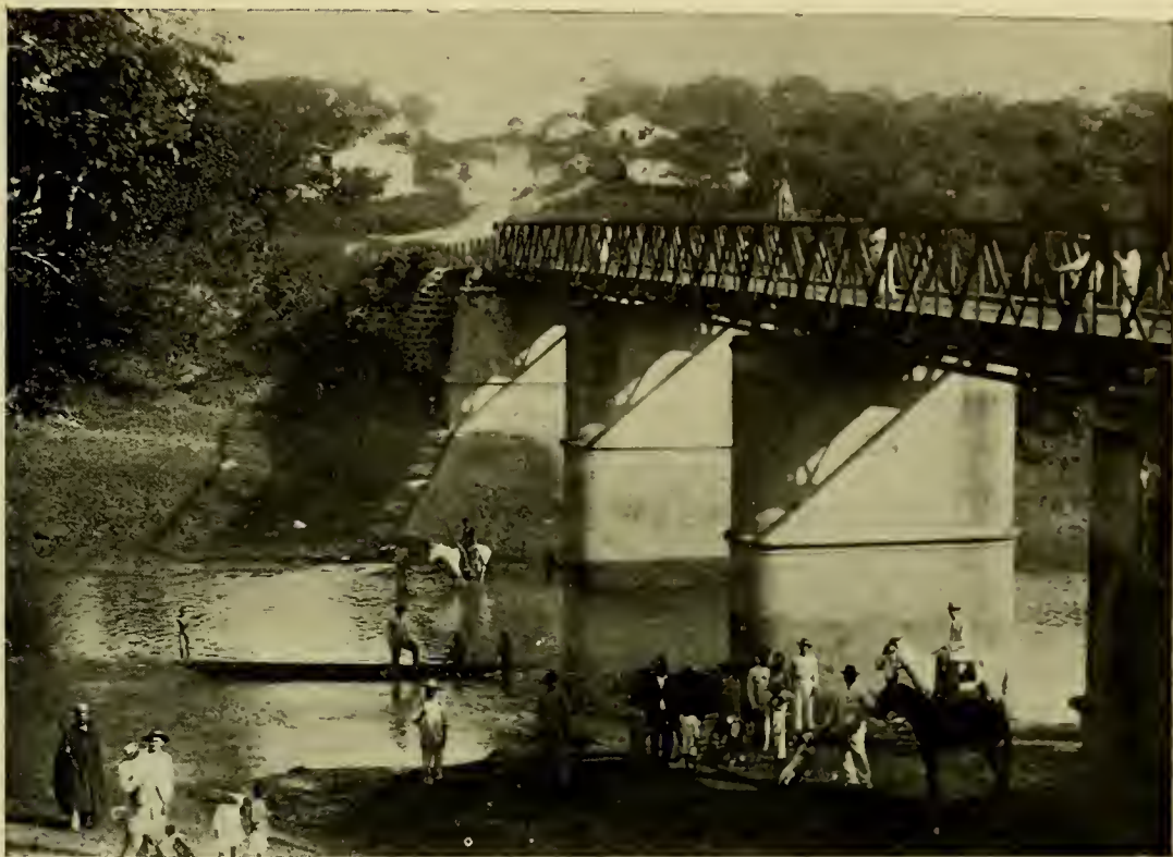
Ponte sobre o rio Coxipó
