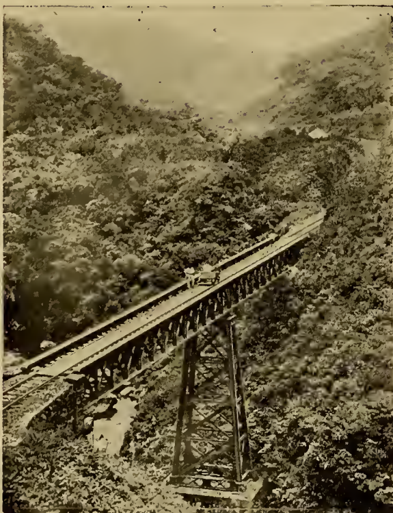
Engenharia brasileira : Ponte sobre o rio Ypiranga, na Serra do Mar. Paraná
