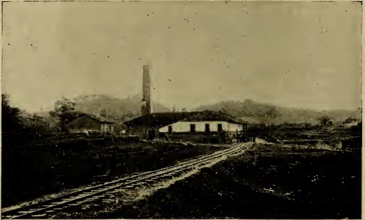
CIDADE DA ESCADA.— Vista da grande usina de assucar Limoeirinho
