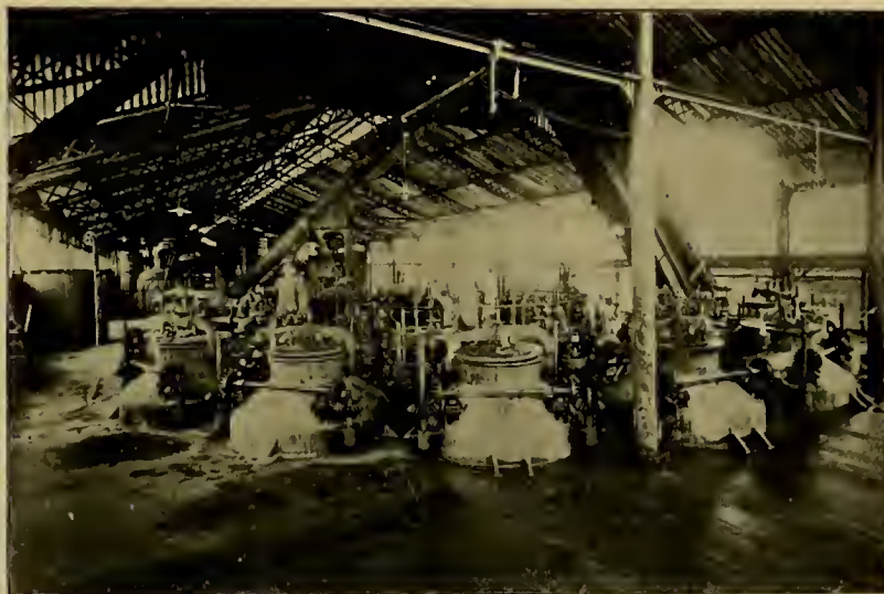
Usina Cucuá — Baterias de diffusão
