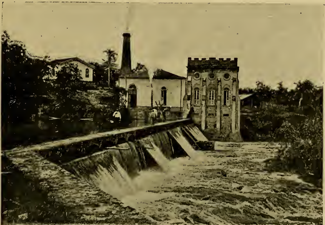
MANAOS — Cachoeira Grande: Captação das aguas para abastecimento da cidade
