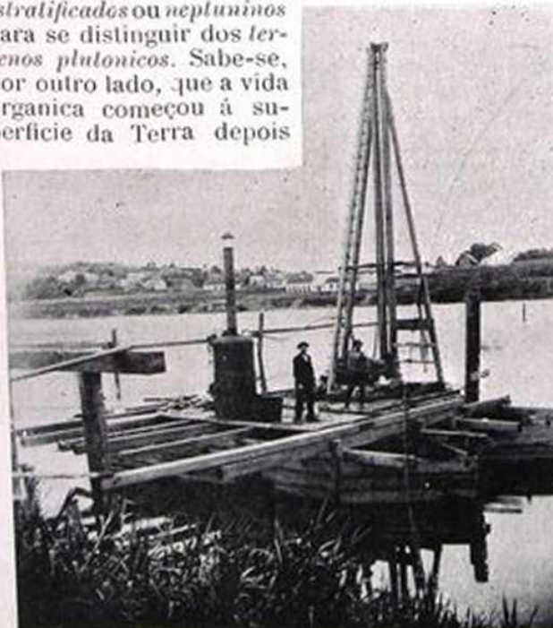
Estado do Paraná—União da Victoria—Bate estacas a vapor da ponte provisoria sobre o rio Iguaçu (phot. amador Egidio Pilotto)
